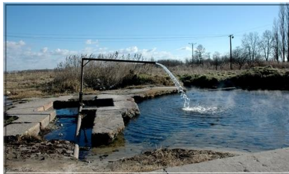
0113/1 helyrajzi számú jelenleg szántó besorolású területén lévő hévíz-kút
